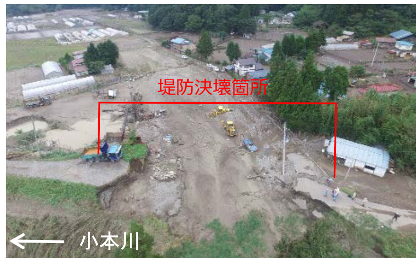
洪水により堤防がこわれている
