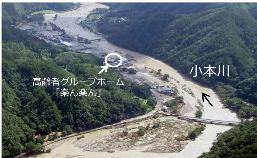
小本川周辺の浸水状況
