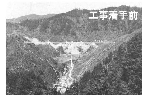
菅沢ダム建設工事の状況
