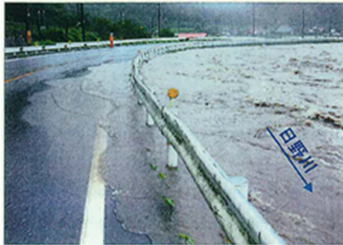
日野郡日野町上菅における国道180号冠水状況
