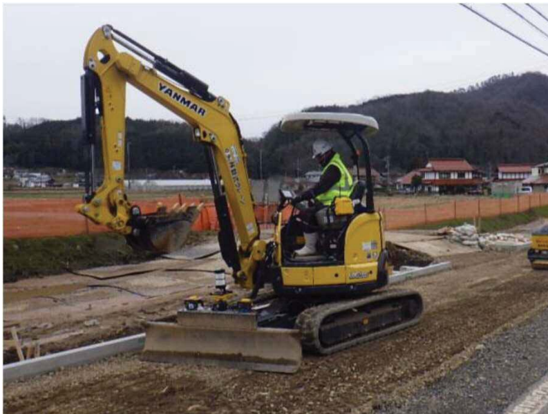
《3Dガイダンスミニショベルによる極小規模土工の施工》
