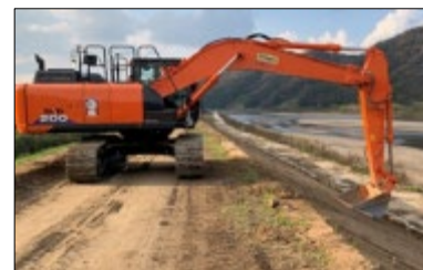
ICT建機による施工
