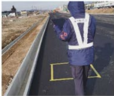
側溝計測
