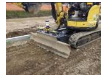
ICT建機による施工
