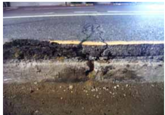
工事中の舗装切断面
