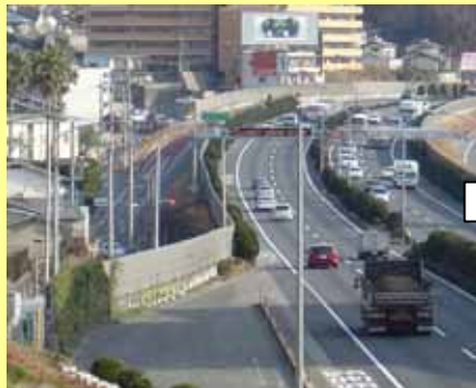
平成16年3月 (施工前)
