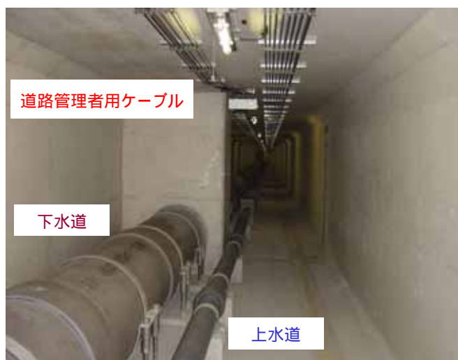
供給管共同溝整備済み箇所(広島市南区宇品地区)
