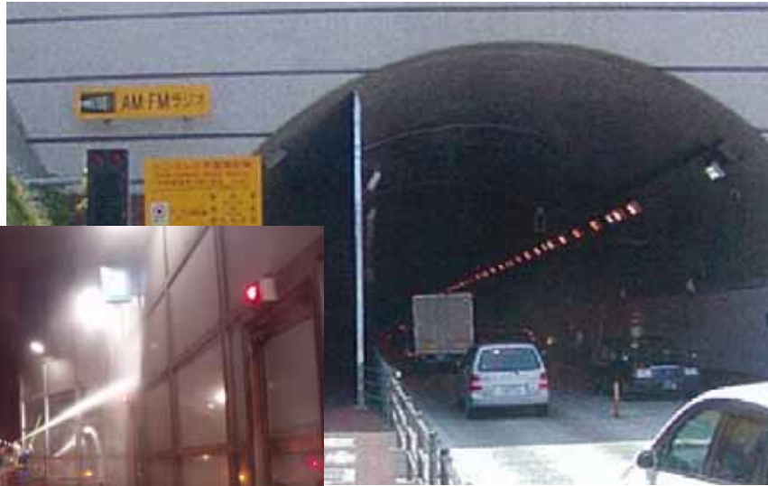
▲ 休山トンネル入口(上り線)
