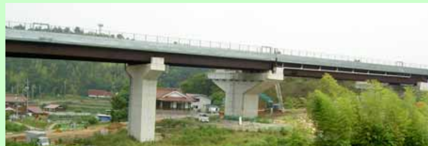
下三永福本高架橋：状況写真
