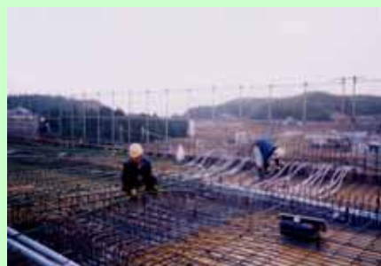
上三永高架橋：施工状況写真
