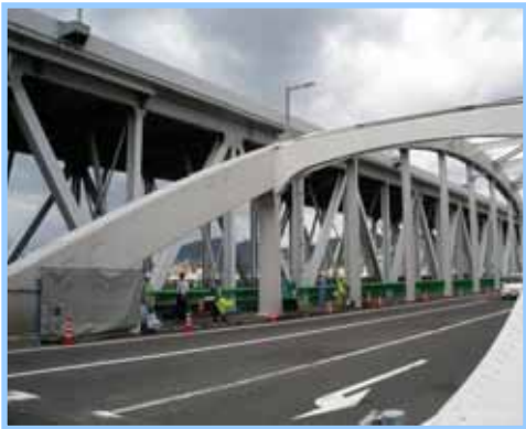
はつり作業の状況 (上り線広島市街側より)
