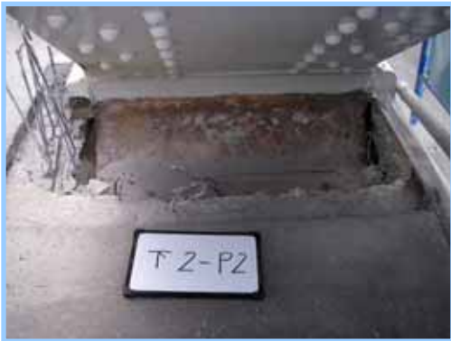
アーチリブ部 はつり作業後
