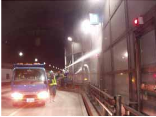
分離壁清掃の様子
