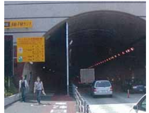
▲ 休山トンネル入口(上り線)
