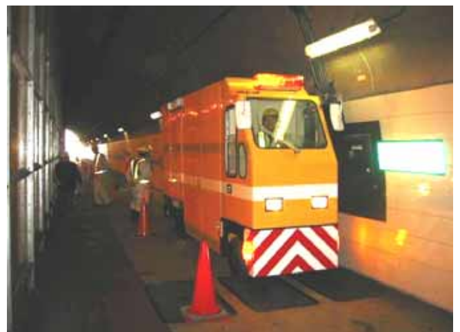
▲ 歩道壁面の清掃時(試験)の様子
