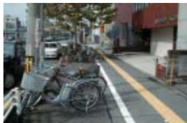
国道2号加古町地区
