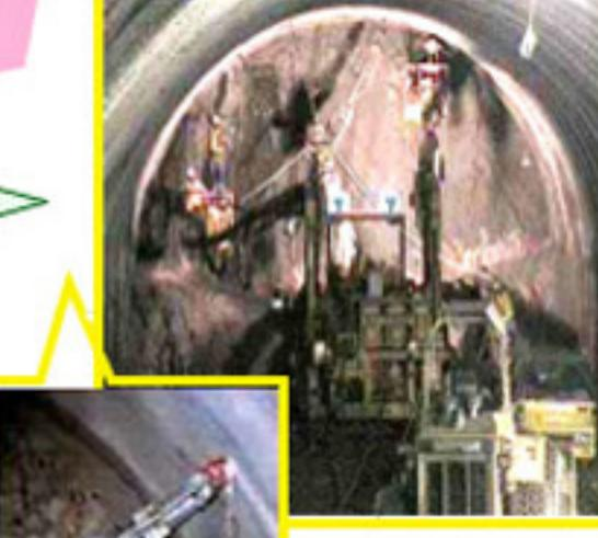
トンネル工事は②から⑥を1~2mの間隔で繰り返しながら掘り進みます。
