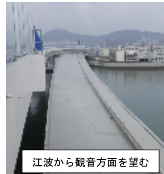
観音大橋の状況
