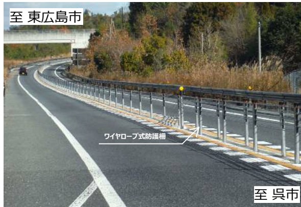
【E75】東広島・呉自動車道(馬木IC～下三永福本IC間)
