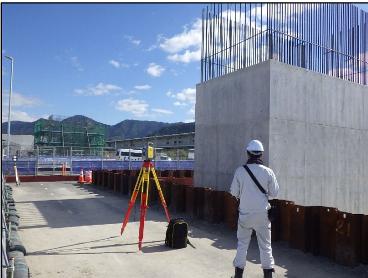
橋脚施工完了部の出来形確認(点群データ取得状況)
