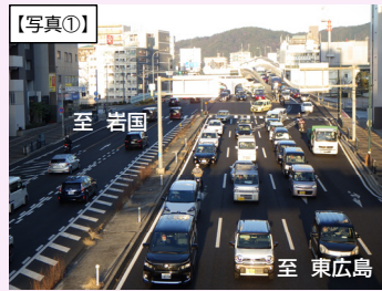
舟入出口付近の状況
