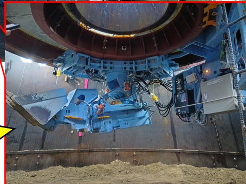
写真① 橋梁下部工(ニューマチックケーソン工)
