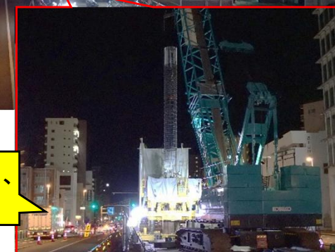
写真③ 橋梁下部工(場所打ち杭工)
