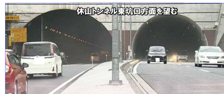
4車線化後の交通状況
