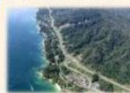
三陸沿岸道路（岩手県山田町）
