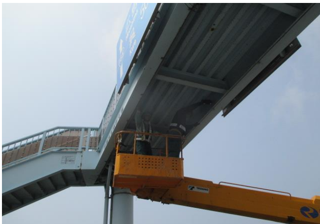
○ 横断歩道橋点検
