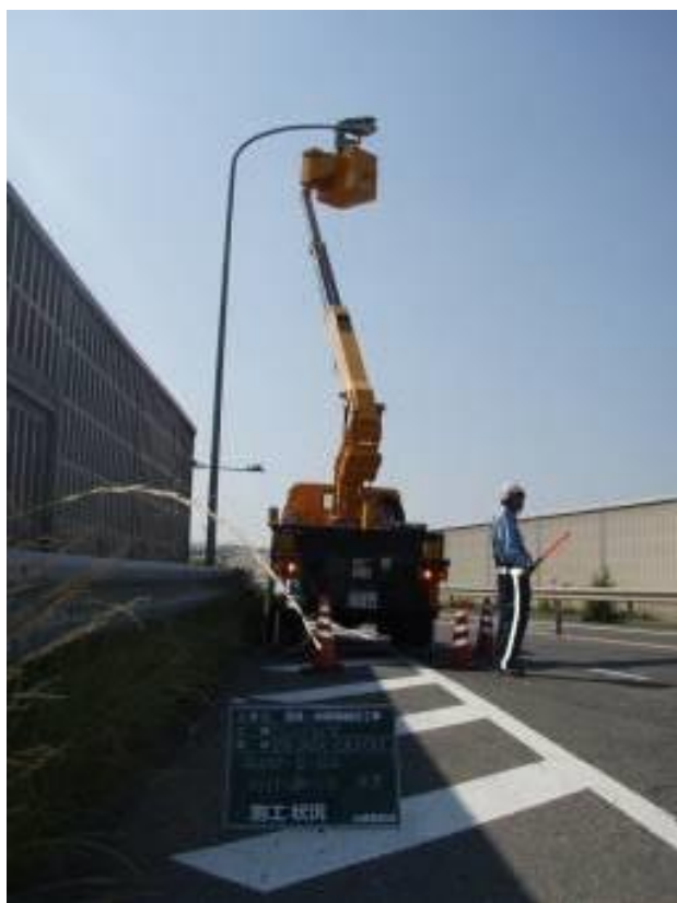
道路照明灯のランプ球替え
