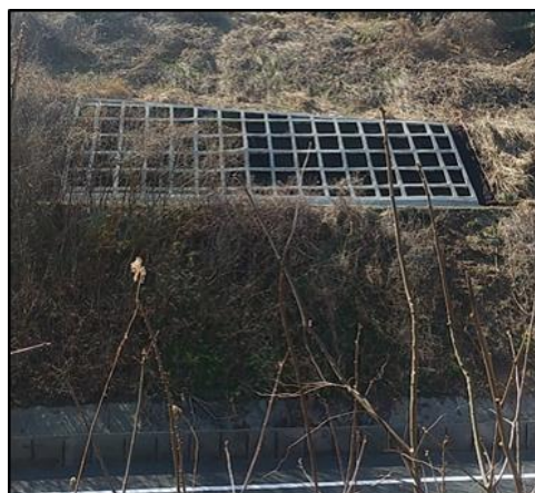
対策後(法枠工)
