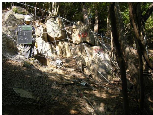
対策後(ロープネット工)
