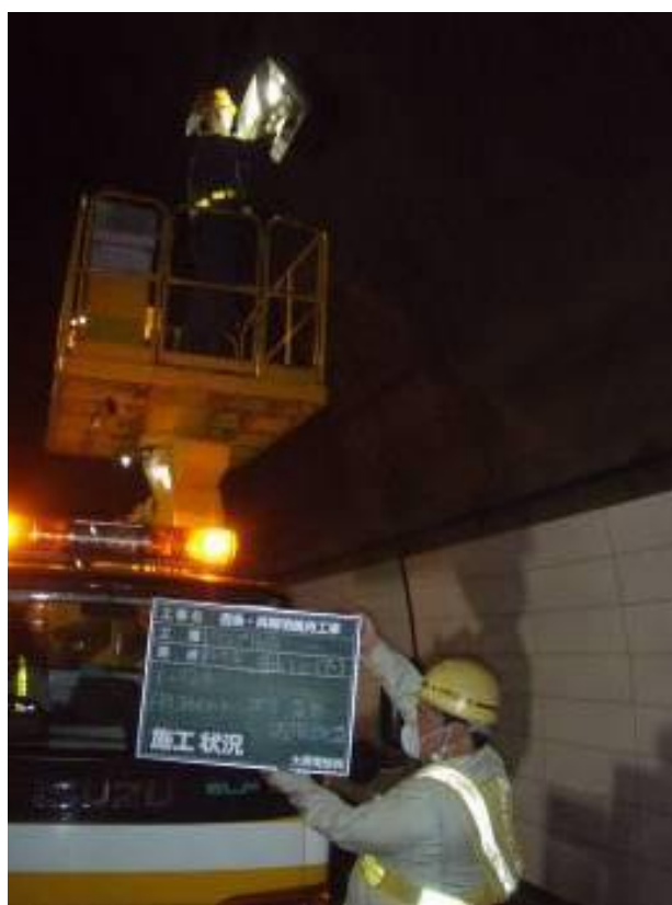
トンネル照明灯のランプ球替え
