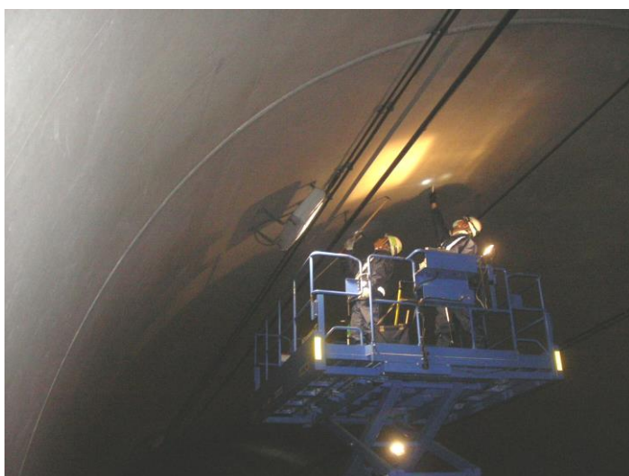
高所作業車による点検 ケーブル付近
