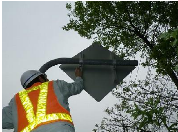
○ 附属物点検（標識）
