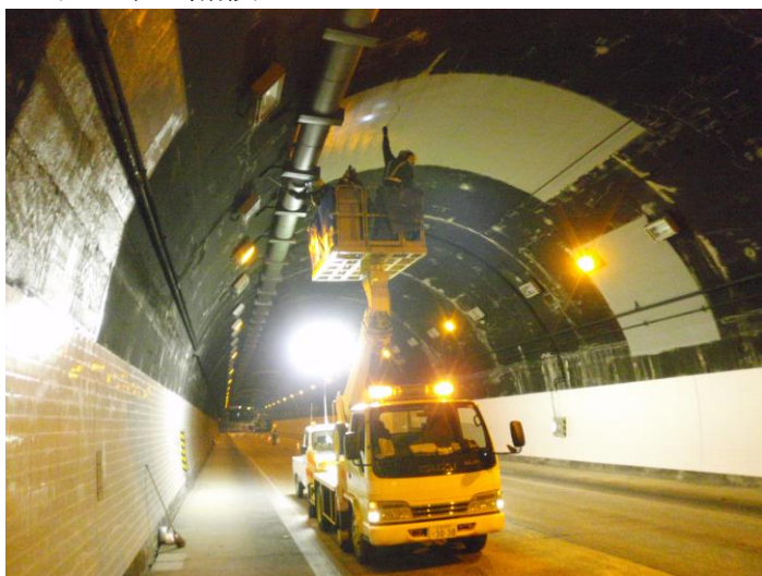
高所作業車による点検 本体工
