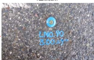
歩道上には控え杭が設置されます
