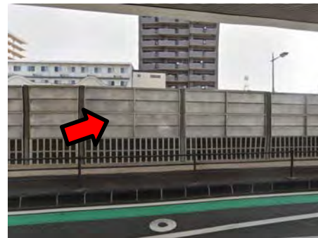
中央分離帯遮音壁 (高さ約3m)
