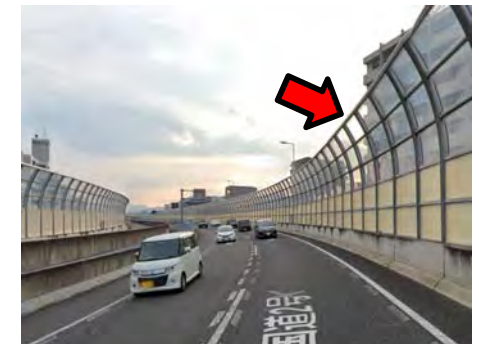
高架部遮音壁(本線部) (高さ約5m)
