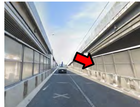
高架部遮音壁(ラフ'部) (高さ約2m)
