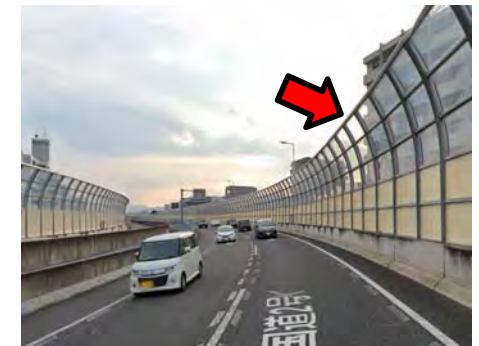
高架部遮音壁(本線部) (高さ約5m)
