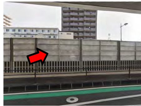
中央分離帯遮音壁 (高さ約3m)
