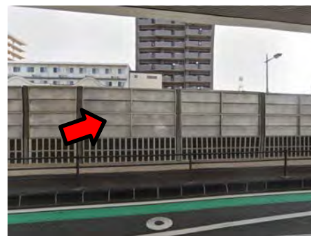
中央分離帯遮音壁 (高さ約3m)
