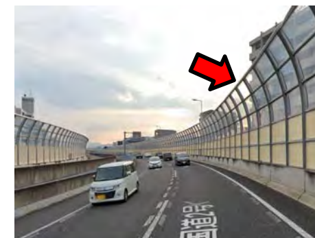
高架部遮音壁(本線部) (高さ約5m)
