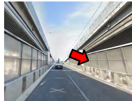
高架部遮音壁(ラフ部) (高さ約2m)
