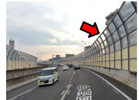
高架部遮音壁(本線部) (高さ約5m)
