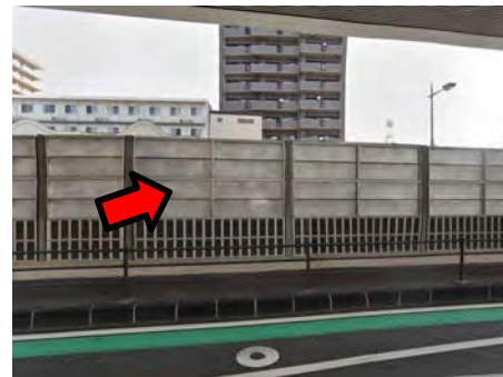
中央分離帯遮音壁 (高さ約3m)
