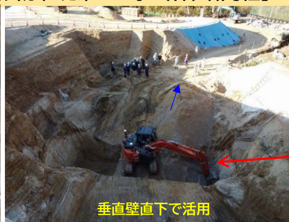
砂防堰堤直下の溪流保全工の掘削で使用
