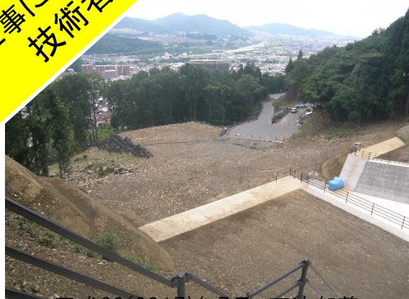
平成29(2017)年7月 下流部着工
