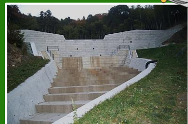
戸坂新町2号砂防堰堤
