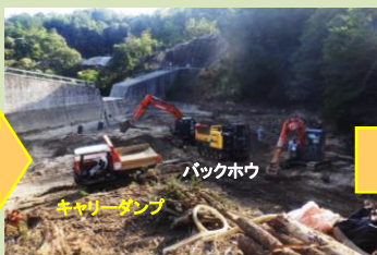
堤内の土砂をバックホウで掘削し、キャリーダンプへの積み込み
