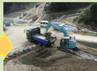
バックホウでダンプトラックに積み込み場外へ搬出
