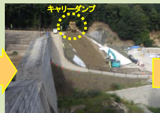
堰堤袖部まで運搬し、袖部から法面(のりめん)下へ土砂を落とす
