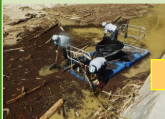
堤内に浮遊している流木類を簡易いかだを使用して集積・撤去
