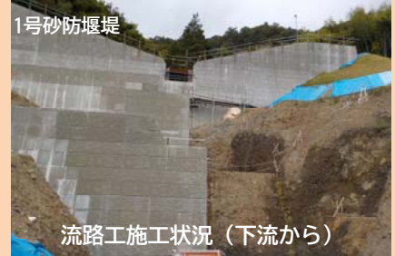
流路工の施工状況
