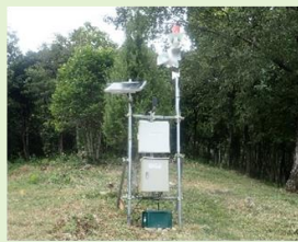
土石流警報装置設置状況
