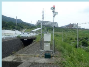
土石流警報装置設置状況
