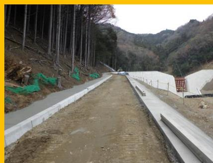
縁石、コンクリート舗装工事を施工しています。
