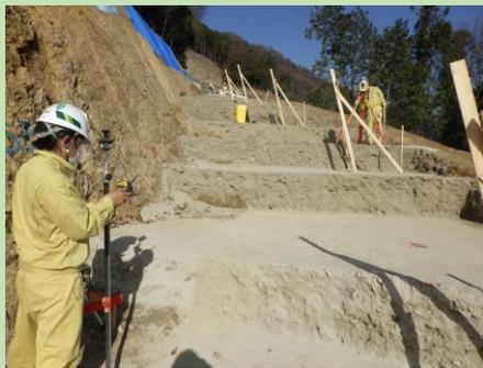
2号管理用道路は掘削が終わり、管理用道路を支える擁壁(ようへき)工事を施工しています。
