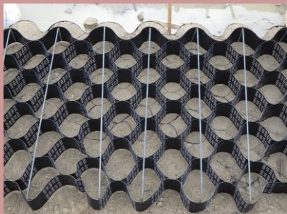
テラセルの型枠を広げた状況
