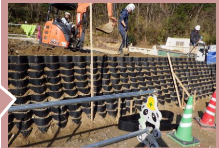
擁壁が積み上がった状況
