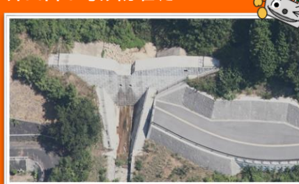
井口台6号砂防堰堤
