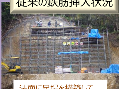
法面に足場を構築して、 ボーリングマシンで施工
