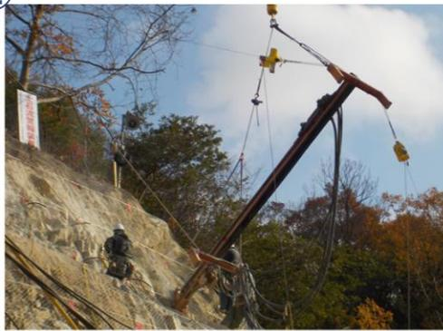
山に鉄筋を打ち込んで地盤を補強します。
