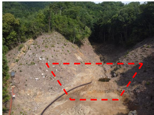
原3号砂防堰堤 着工時
