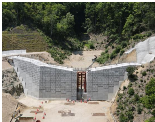
原3号砂防堰堤 本堤完成
