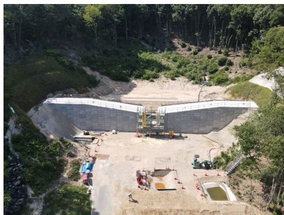
原2号砂防堰堤 本堤完成
