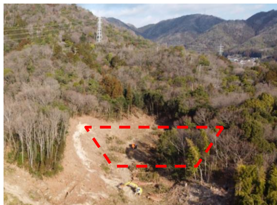
原2号砂防堰堤 着工時
