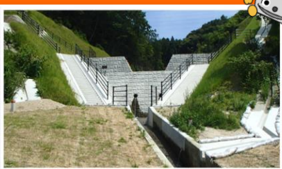
五月が丘2号砂防堰堤
