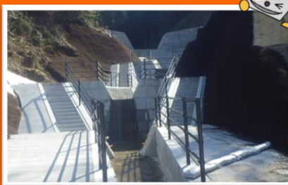
五月が丘3号砂防堰堤
