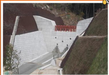
五月が丘1号砂防堰堤
