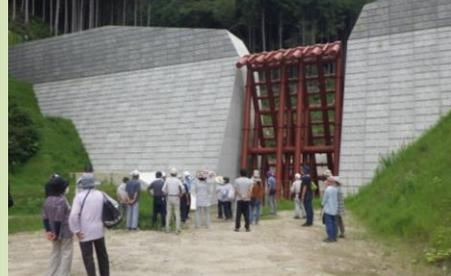
透過型の砂防堰堤です。(堰堤に隙間が
