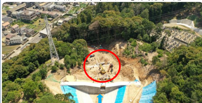
流路工(下流に水を安全に流す施設)の施工しています。
