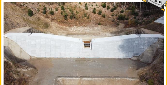
令和4年12月 本堤完成
