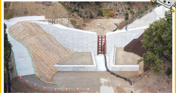
令和4年12月 本堤完成
