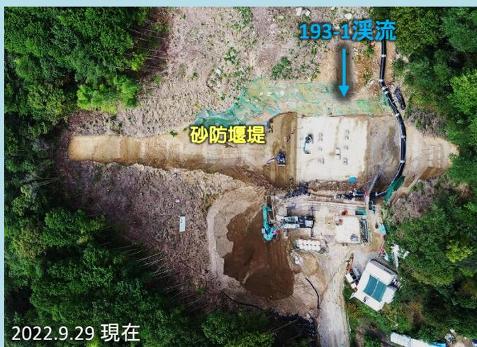
砂防堰堤の底部分の地盤を改良しています。
