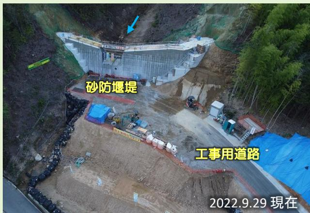
砂防堰堤本体をつくるためのコンクリートを打設しています。
