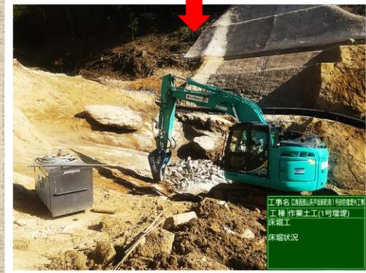
堰堤が建設される基礎部分の掘削は、硬い岩に苦戦しました。
