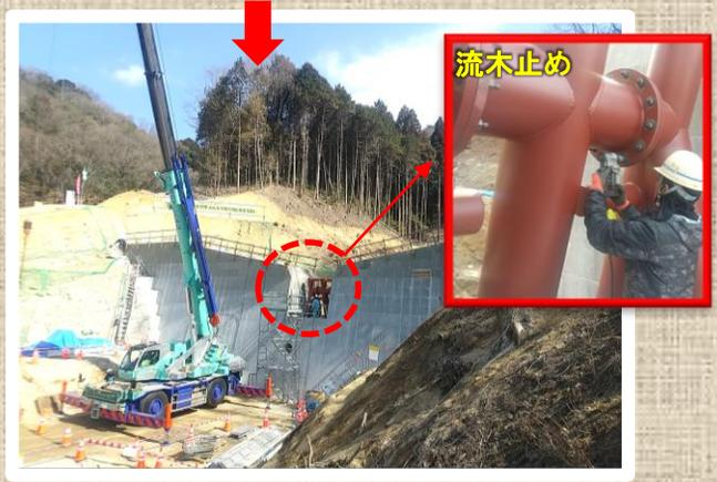
本堤の打設が終わり、水通し部分に鋼製スリット（流木止め）を施工しました。
