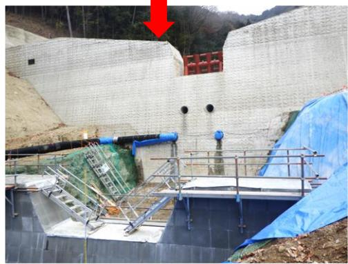
前庭保護工（水叩き、第一垂直壁、側壁護岸）を施工しました。（堰堤の基礎部分を保護する施設）
