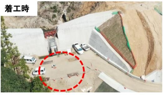
2号堰堤は、本堤工事が令和3年3月に完了していたので、今回は溪流保全工と管理用道路を施工しました。
