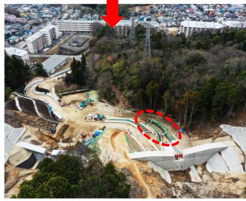
2号堰堤の流路（下流に水を安全に流す施設）を施工しました。（写真ではまだ途中で）
