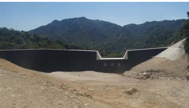
上流側の状況
