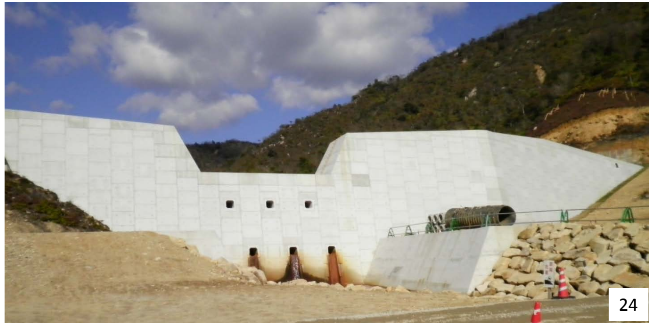
山口県防府市 (堰堤本体に砂防ソイルセメント (現地の土砂とセメントを混合)を 使用した例)
