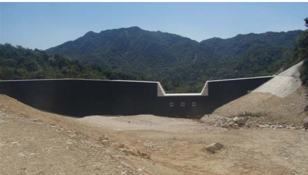
上流側の状況
