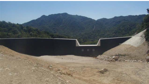
上流側の状況
