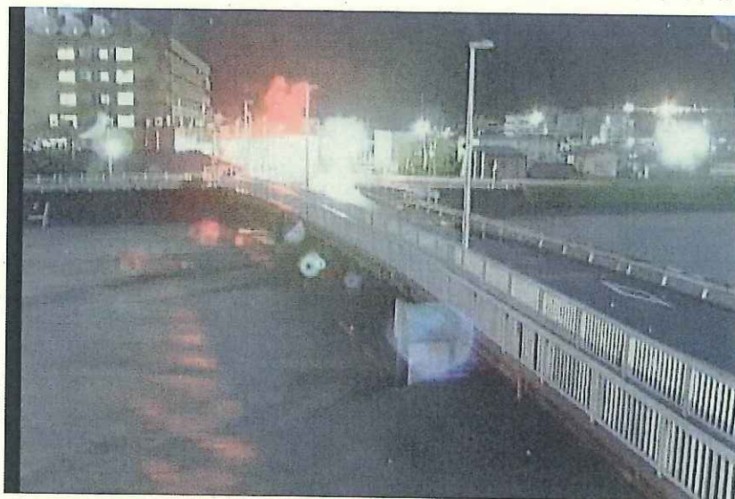
新川橋水位観測所状況 ( 8/20 5:00 頃 )
