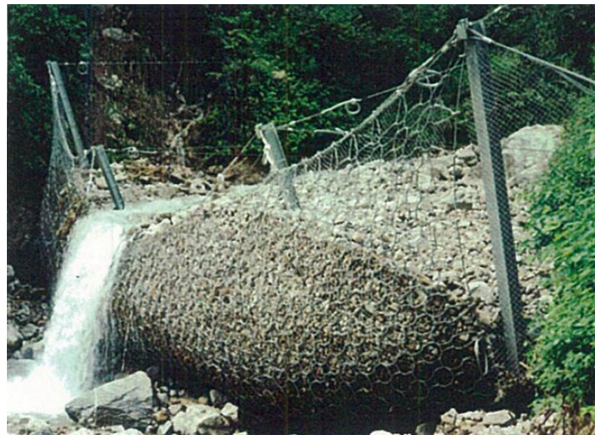
土石流の捕捉状況
